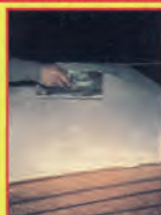
Spalmatura colla GEOLIS. Usare spatola dentata da 10 mm
