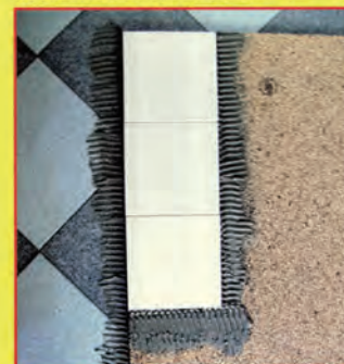
SI con ASSO: acustica e termica sui pavimenti esistenti (usare collanti LIS tipo X100)
