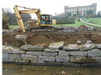
pristinata l'arginatura in destra idraulica, erosa a causa del sormonto delle acque di piena. Sempre sul Cessana a Buggiano saranno ricostruiti due tratti di muro mediante la posa in opera di una scogliera in massi anche per contrastare l'erosione del fondo alveo. In località Bellavista, nel comune di Buggiano, saranno ripristinati i cedimenti arginali a valle e a monte del ponte di via I Maggio mediante la posa in opera di scogliera e la realizzazione di un nuovo muro in scogliera di massi.
