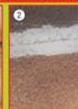
Stuccatura del giunto con colla.
