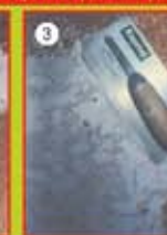
Posare la rete in fibra di vetro rasando con colla.
