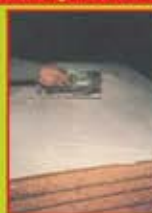
Spalmatura colla. Usare spatola dentata da 10 mm
