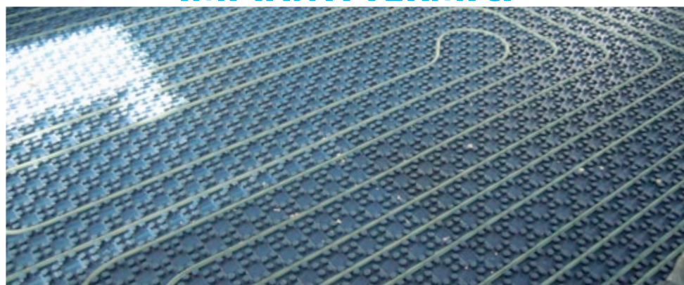
Sistema radiante a pavimento
