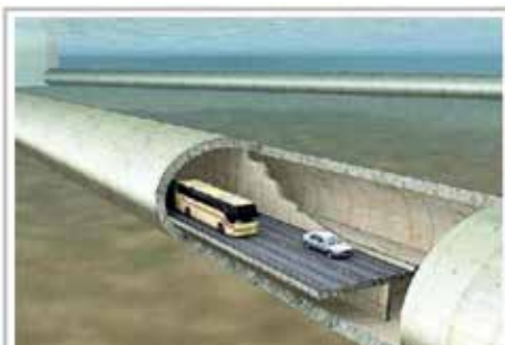
un'idea del tunnel ipogeo
