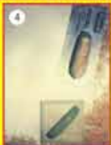
Finitura con intonaci spessore max 2/3 mm
